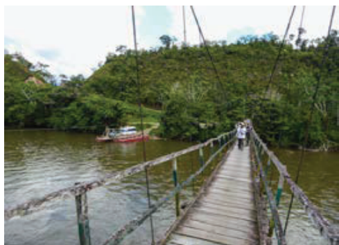
453 Puente de Sumayaku and Nangaritza River
